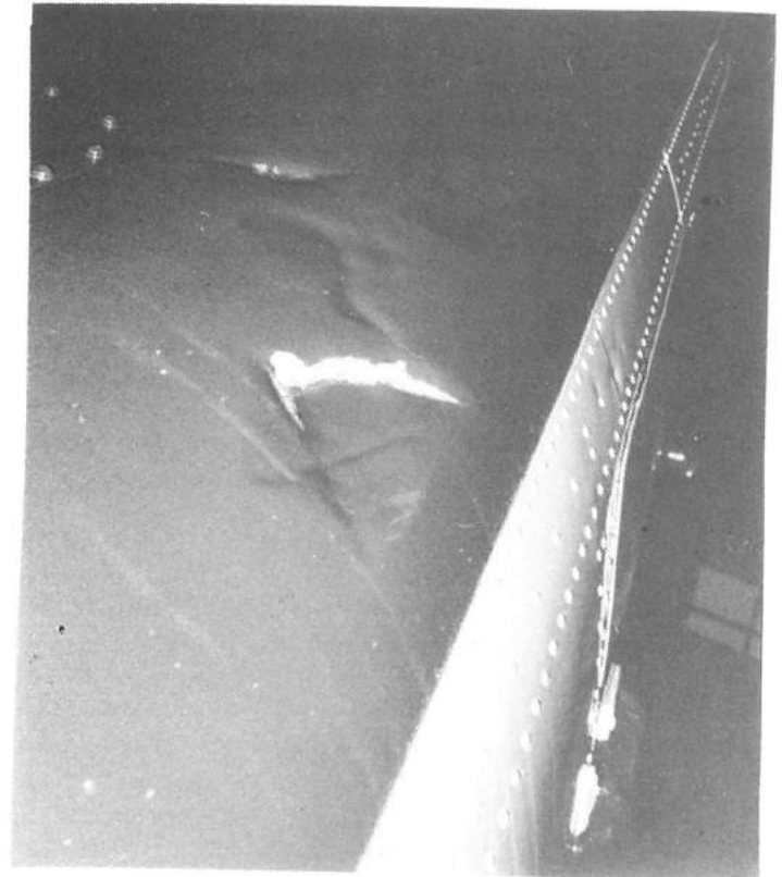
Bild 13. Tryckskador i skalet under stjärtbom.
