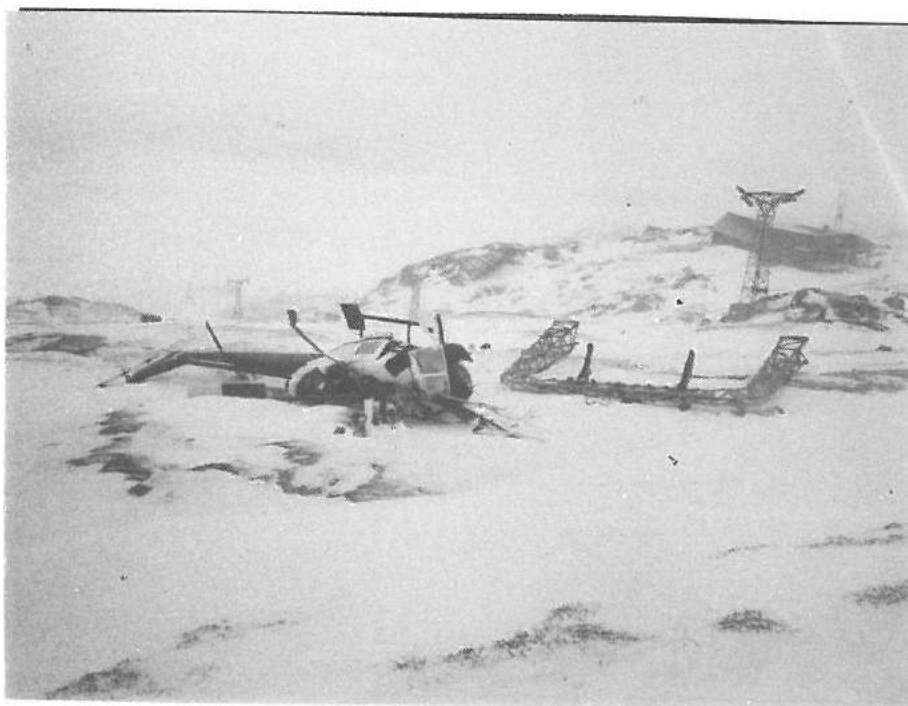
Bild 10. Helikoptervrak och portal. Bladets slagriktning från höger mot vänster i bilden.
