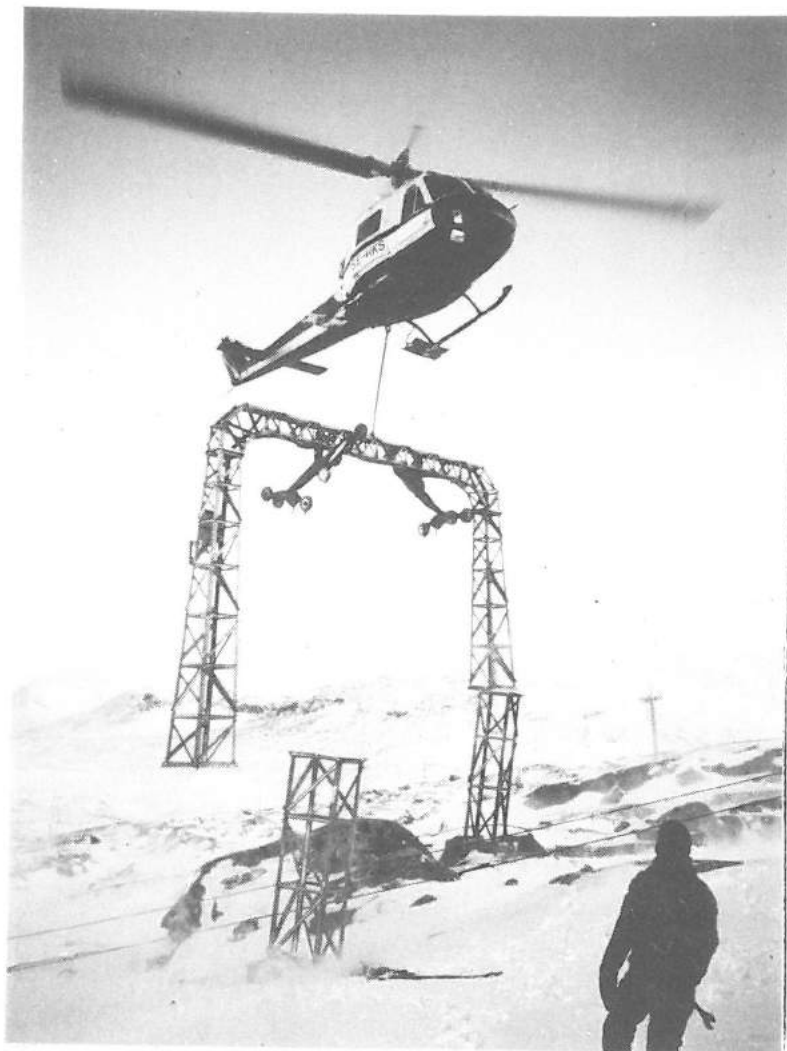
Bild 3. Portalen har lyfts av underlaget. Helikoptern har vridits vidare upp mot vinden. Det långa benet har sjunkit något jämfört med stumpen.
