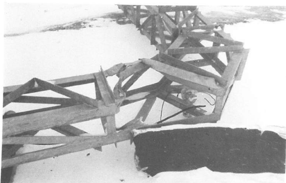
Bild 8. Portalen med del av bladet som slagit i över- liggaren.
