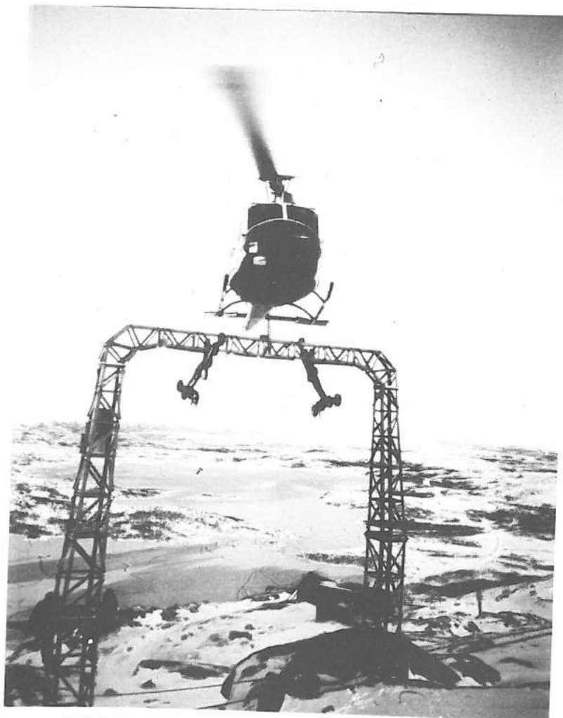
Bild 1. De sista bultarna tas bort.
