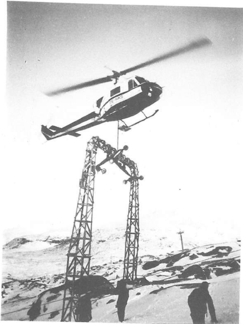
Bild 2. Föraren försöker lyfta. Stroppen är stramad och helikoptern har börjat vridas upp mot vinden.
