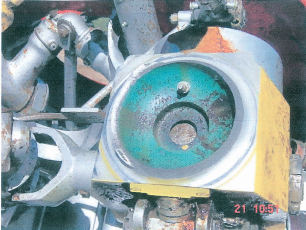
Rotore principale - particolare rottura zona attacco radice pala
