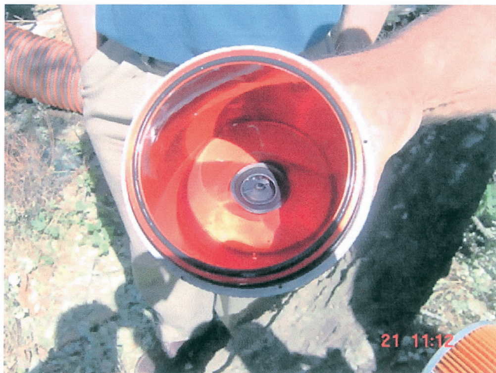
Verifica pulizia filtri carburante
