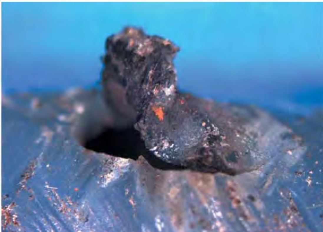
Particolare foro nella tubazione in teflon.
