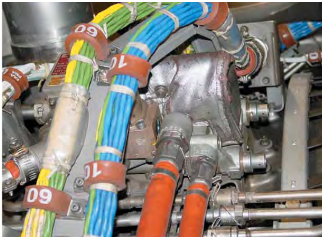
Motore famiglia PW 4000. Particolare installazione tubazioni flessibili CP11 e CR13.
