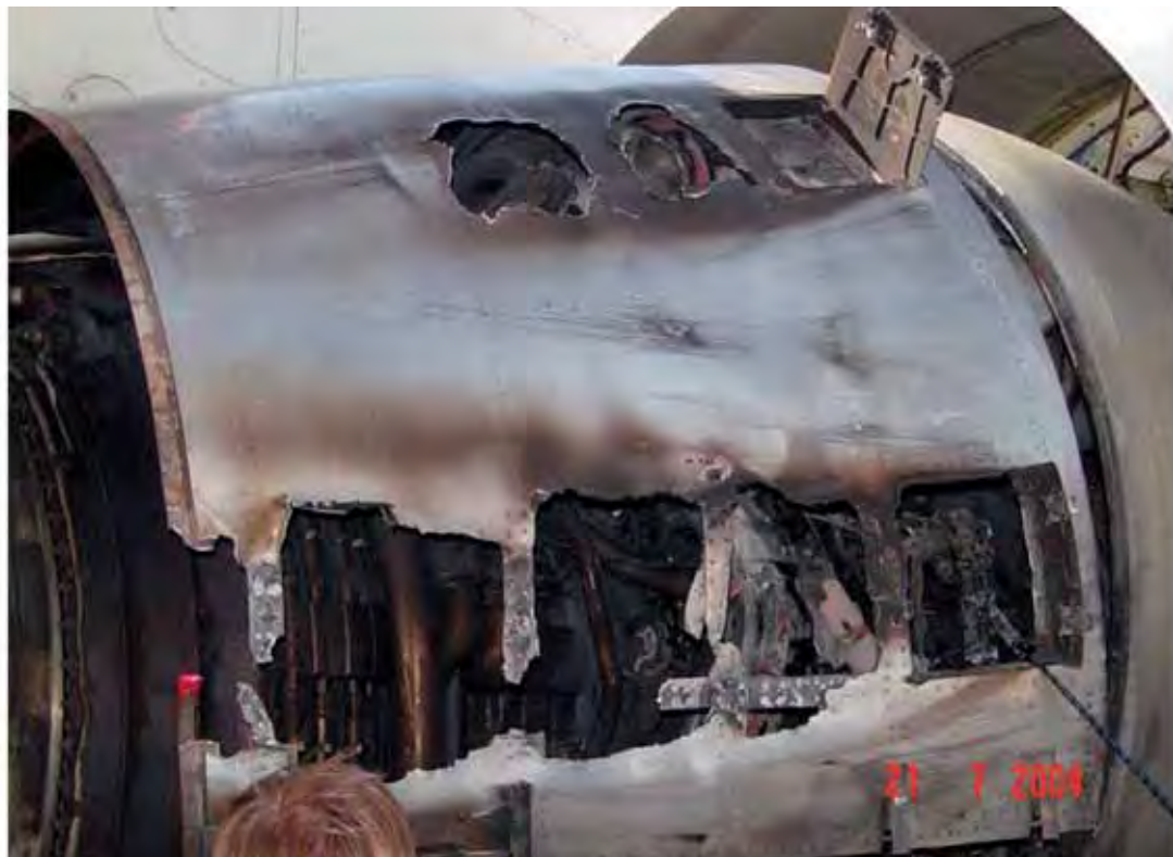
Motore destro. Vista lato destro.
