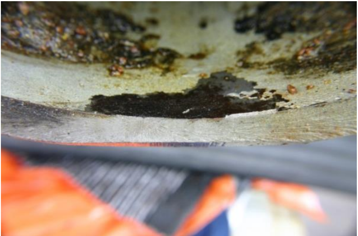
Abbildung 5: Bruch mit Ausgangspunkt
