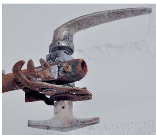
Foto n. 10: particolare del sistema di chiusura del tettuccio scorrevole.
