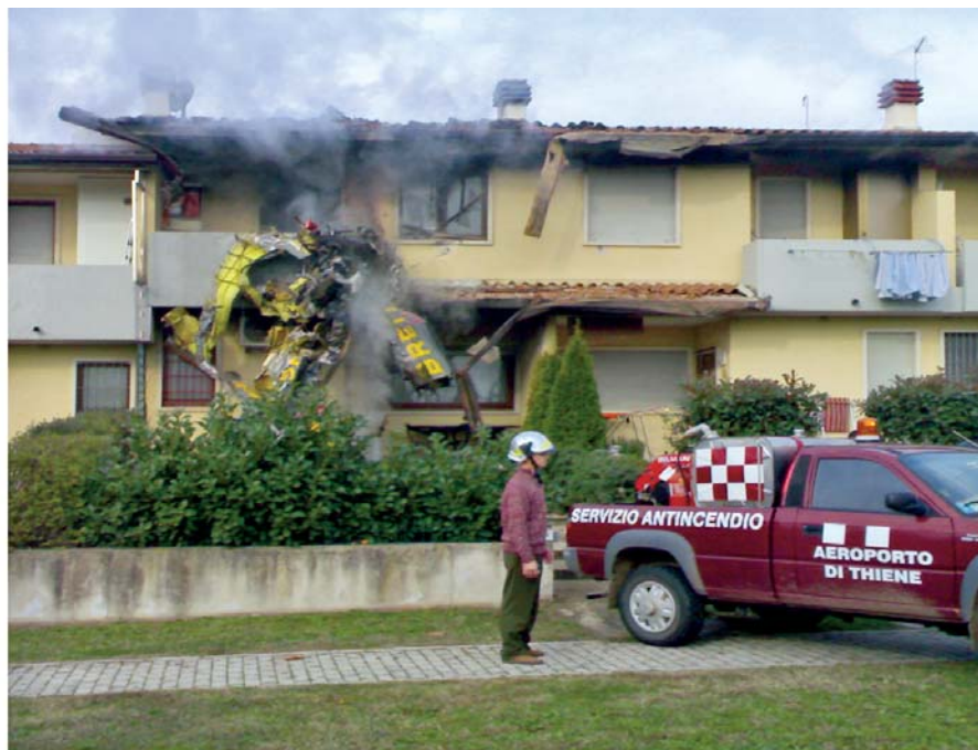
Foto n. 3: immagine ripresa poco dopo lo spegnimento dell’incendio da parte del mezzo del servizio antincendio aeroportuale (autocarro TATA), visibile sulla destra.
