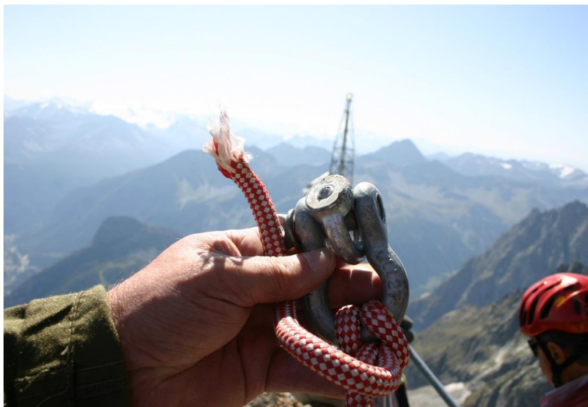
Foto 14: golfare strappato dalla roccia.
