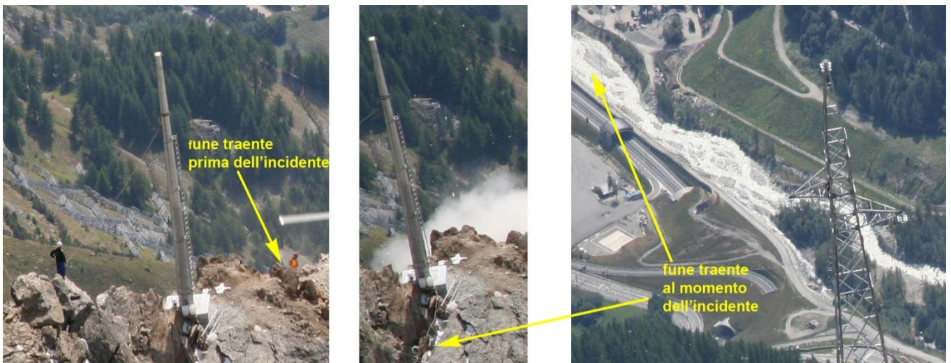
Foto 22: disposizione fune traente prima e subito dopo l'incidente.
