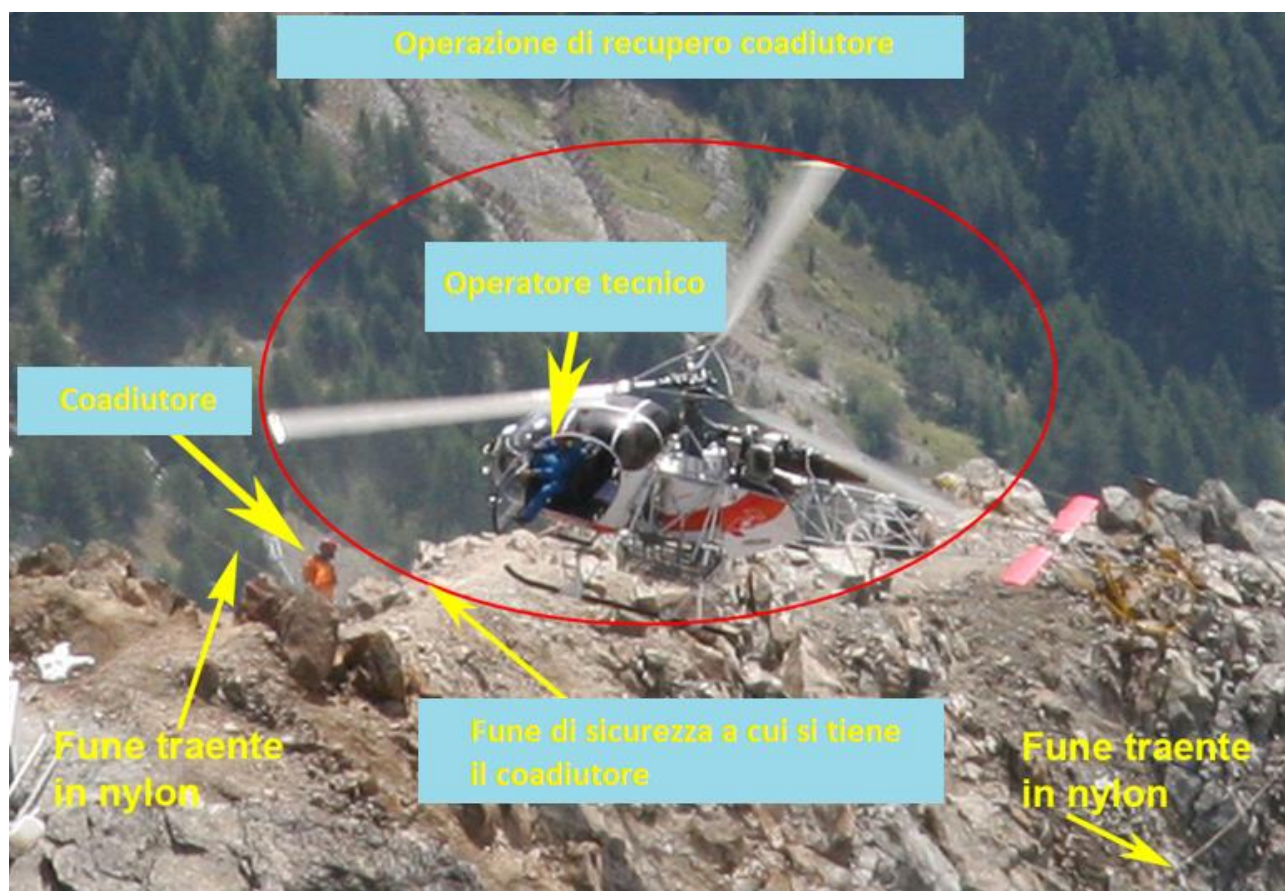
Foto 24: elicottero in avvicinamento alla posizione del coadiutore tecnico.
