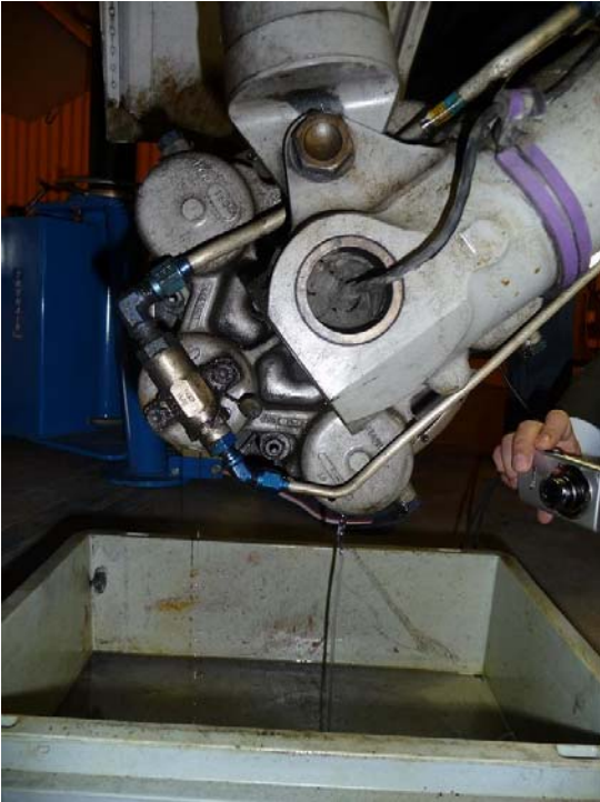
Figuur 8: detailfoto waarop is te zien dat hydraulische vloeistof uit twee remcilinders van de linkervielspoot loopt
