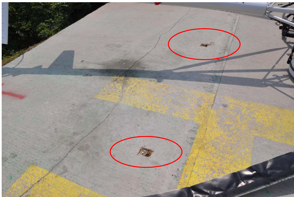
Foto 2: particolare dei ganci presenti sulla piazzola.
