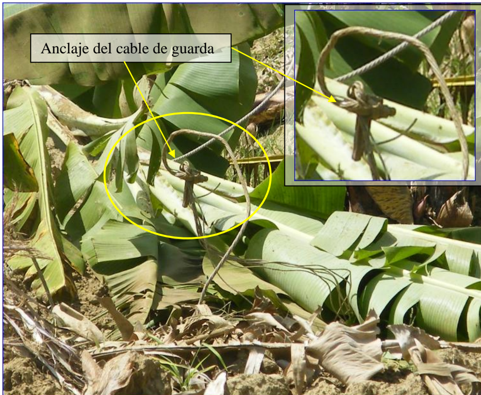
Imagen 03.- En el círculo se puede apreciar el anclaje del cable de guarda y en el sobrecuadro la imagen ampliada del mismo.
