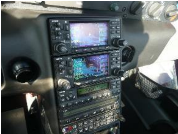
Slika 25. Radio stanice i audio panel tijekom provjere
