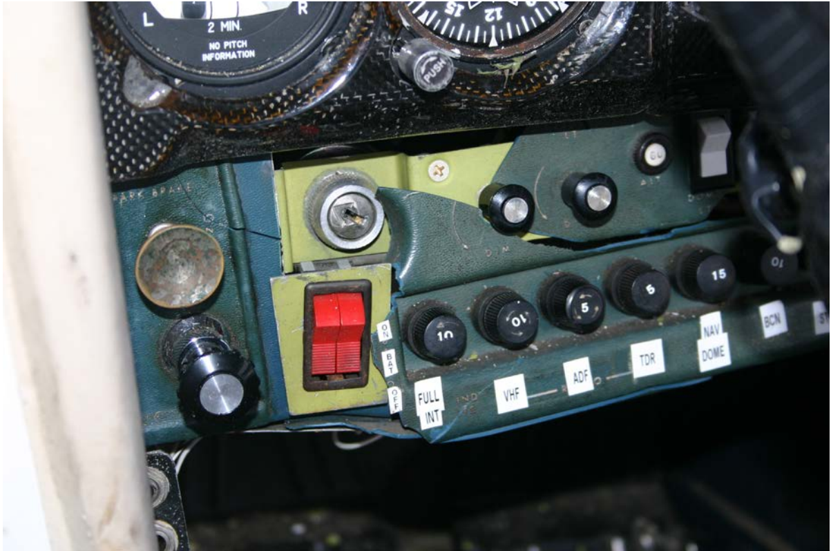
Foto 10: parte sinistra in basso del pannello strumenti (in rosso gli interruttori della batteria e del generatore).
