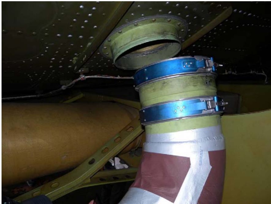
圖 1.16-1 脫落之 3 號空調機空調管
