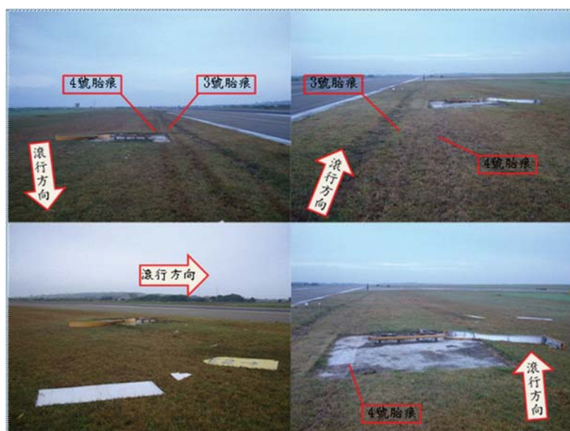
圖 1.12-4 主輪滾行胎痕與損壞指示牌
