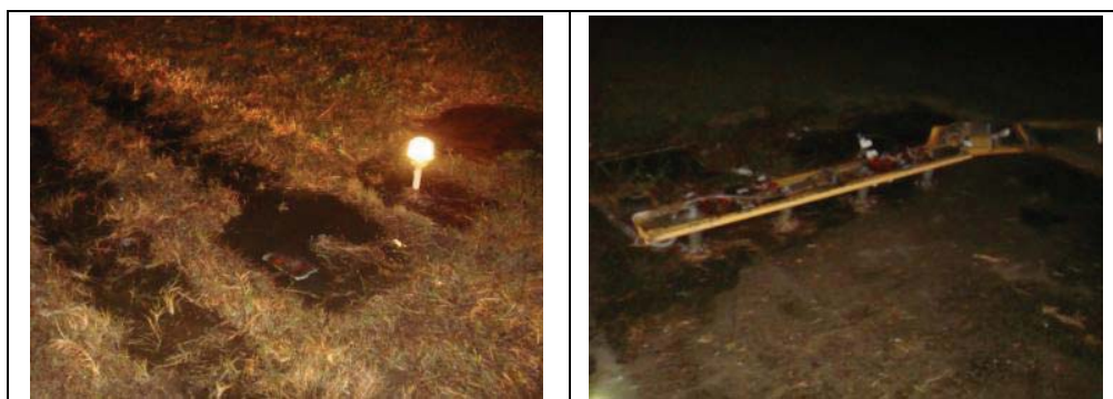
圖 1.10-3 損壞跑道燈及指示牌
