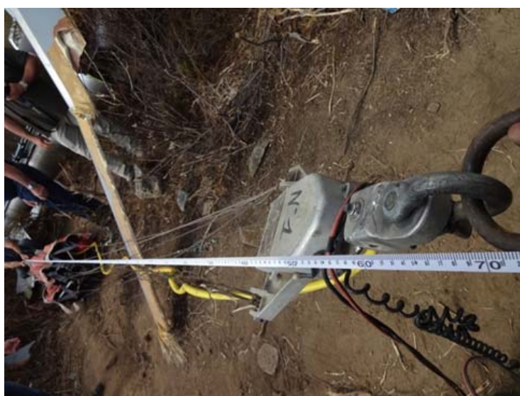
Foto 20: operazione di misurazione della lunghezza della benna.
