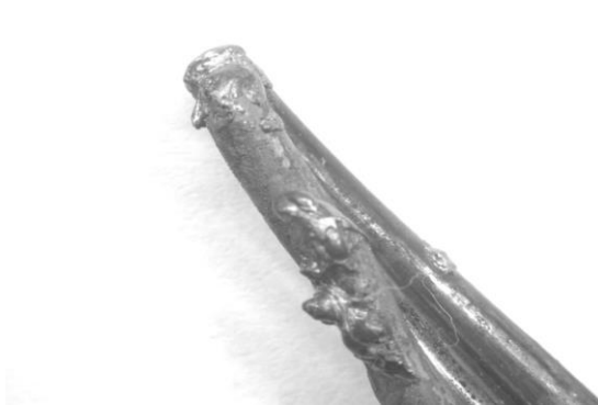
Foto 24: fusione e rottura fili cavo elettrodotto lato Ovest.
