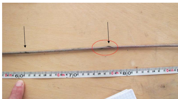
Foto 18: segni danneggiamento termico cavo verricello.
