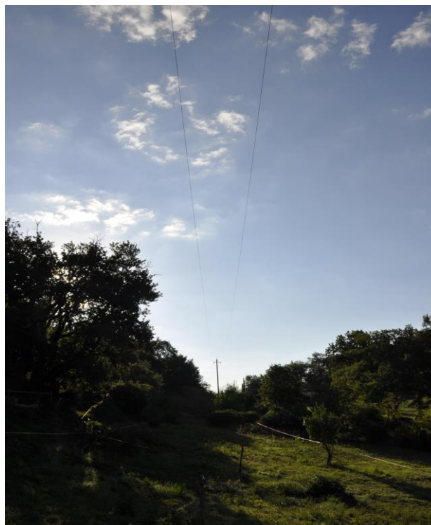
Foto 30: elettrodotto in direzione Sud-Sud Est.
