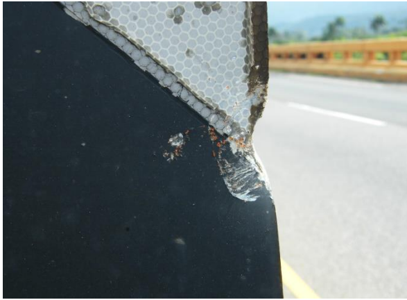
Marca de impacto dejada por el ala izquierda en la señalización vial.
