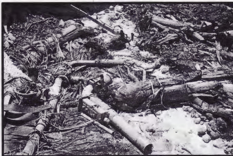
Fotografía No.: 7 Daños en el sistema de aspersión.
