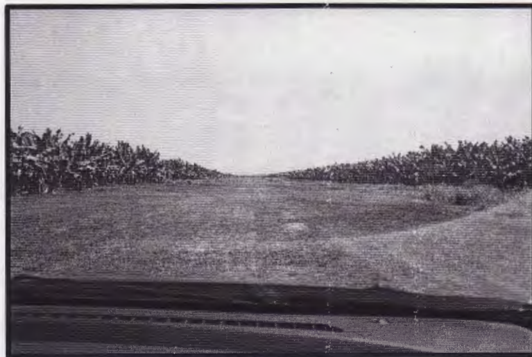
Fotografía No.: 14 Vista panorámica de la pista.
