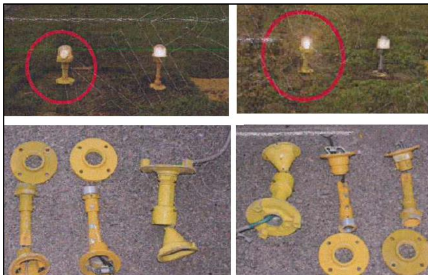
圖 1.10-2 臺中機場 36 跑道左側 2 邊燈毀損圖
