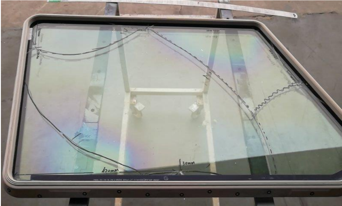
图 93 内层玻璃碎裂情况(参见附录 1_Ref.8)
