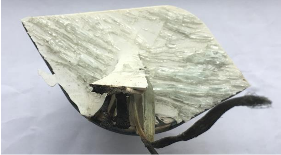
图 31 玻璃起裂点位于导线引出端
