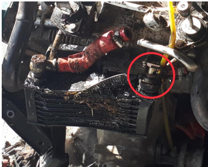
Foto 27: per poter separare il motore la tubazione collegata al radiatore è stata scollegata, svitando il bullone di fissaggio. Indicato dal cerchio rosso il punto di attacco al radiatore. La vite è stata parzialmente riposizionata nella propria sede dopo la rimozione della tubazione.
