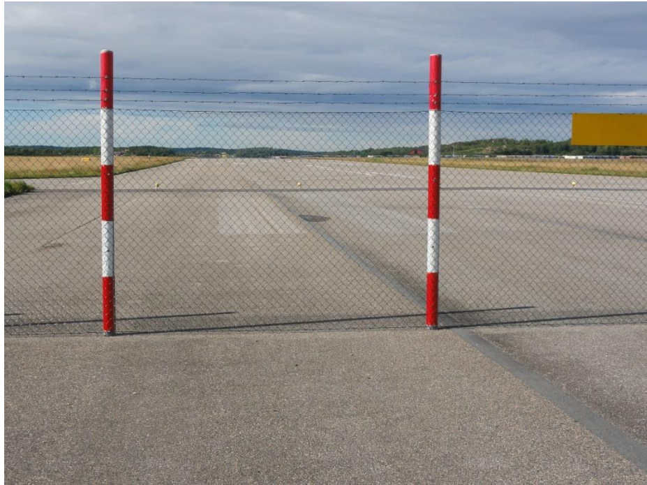
Figur 19. Staketet som skiljer airside från landside 160 m söder om tröskeln bana 01.
